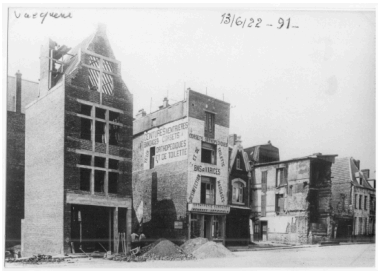
Arras. Place de la Vacquerie. Photographie, 1922 (Médiathèque d'Arras ; 189).
