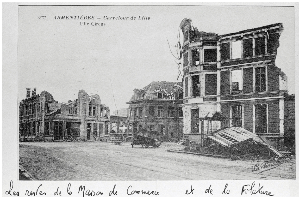
Maison de commerce détruite des établissements Pouchain. Photographie, [vers 1918] (coll. part. Delepouille).
