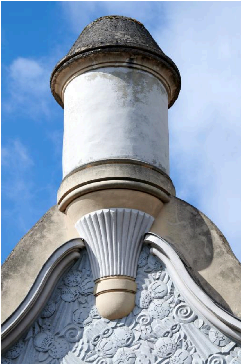
L'un des deux lanternons de la façade principale.
