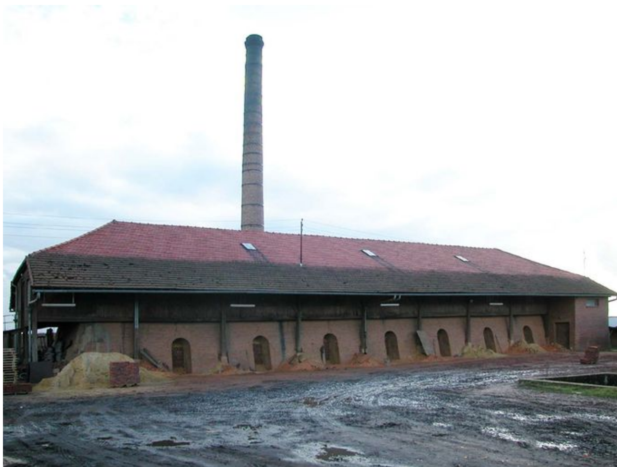
Vue d'ensemble du four de cuisson et de la cheminée.
