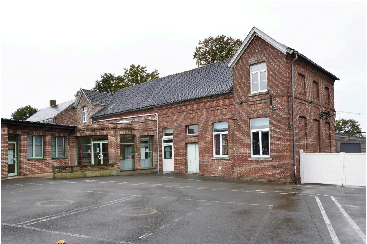
Bâtiment principal, façade sur cour.
