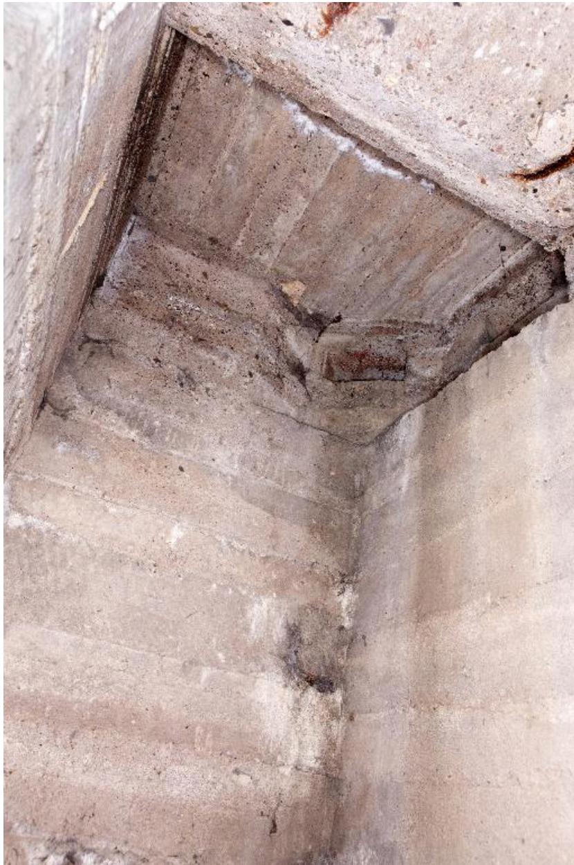
Salle ouest, en contre plongée, l'observatoire
