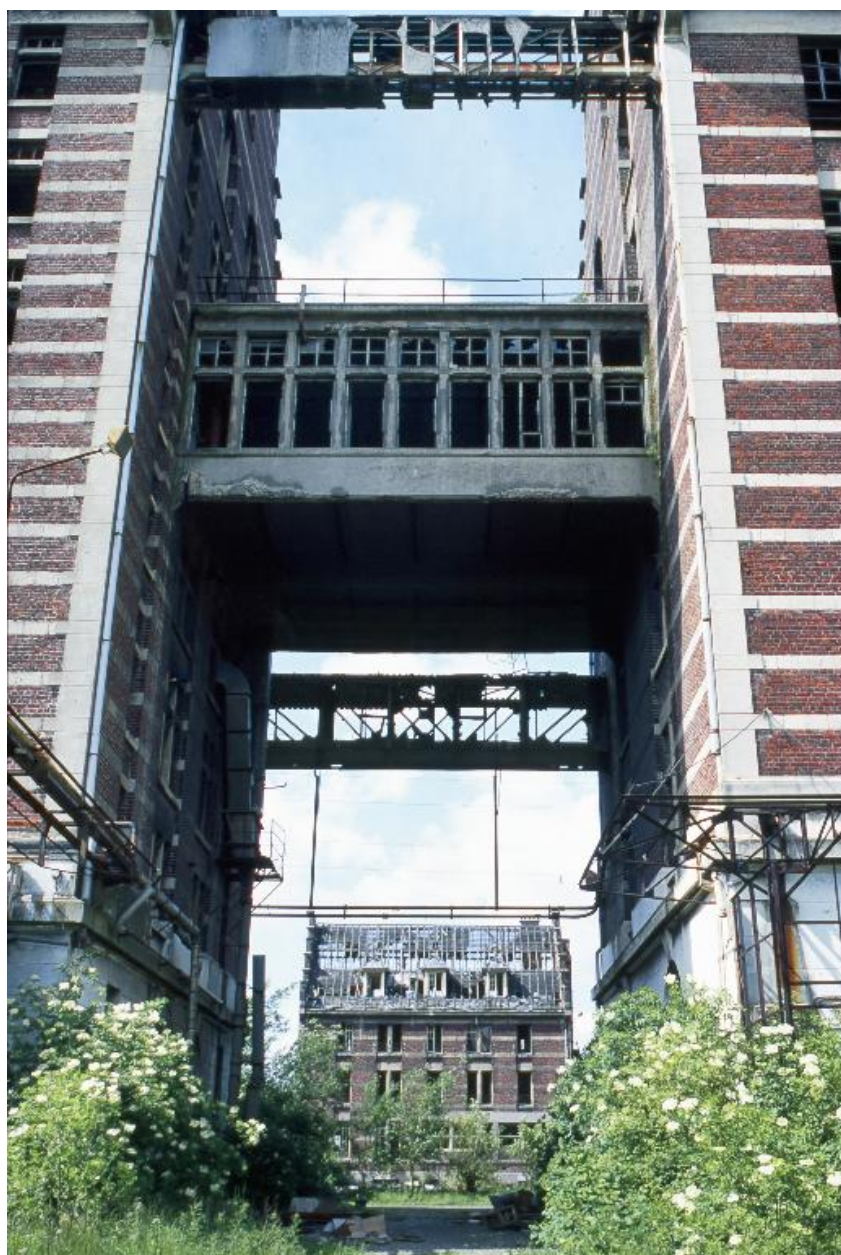
Passerelle au 3e étage reliant la salle des moteurs aux silos à farine. Vue en contre-plongée vers le nord.
