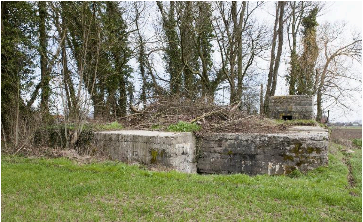
Vue générale vers le nord-est
