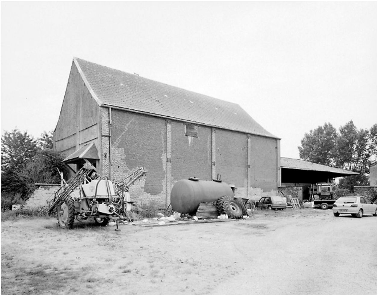
Vue de la grange.
