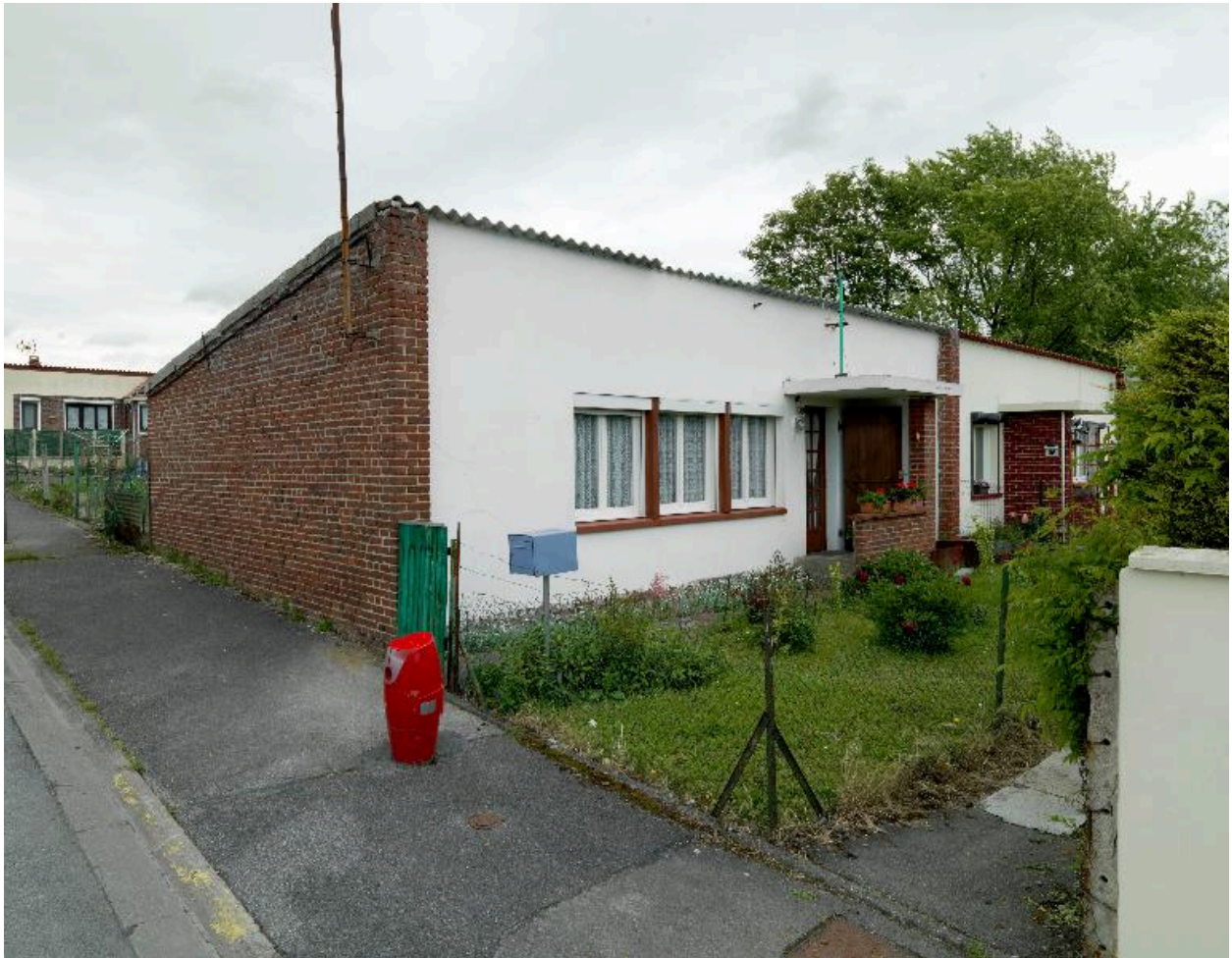
Vue d'un des logements de la cité.
