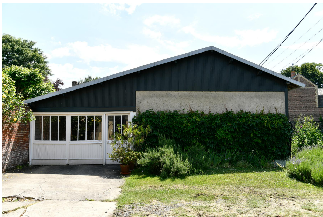
Baraquement provisoire du magasin Hua, vue depuis l'ouest.
