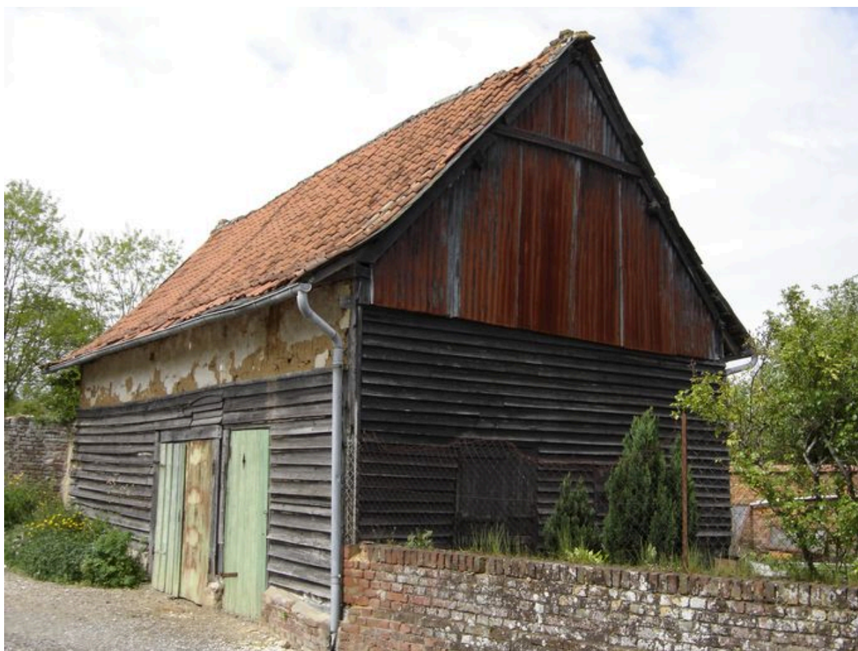
Vue détaillée de la grange.
