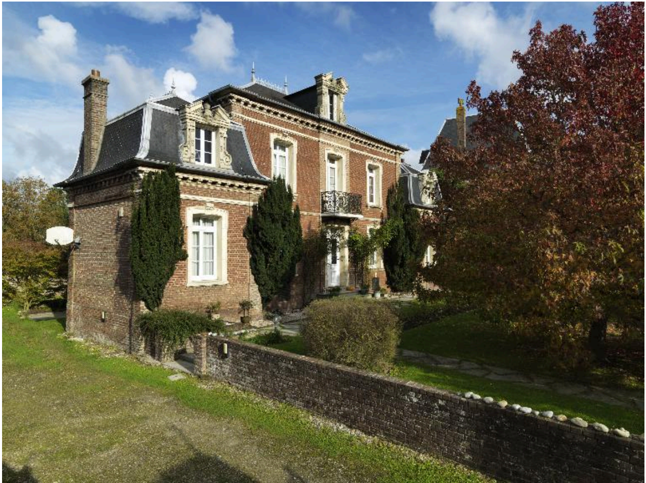
Façade principale, vue de trois-quarts.
