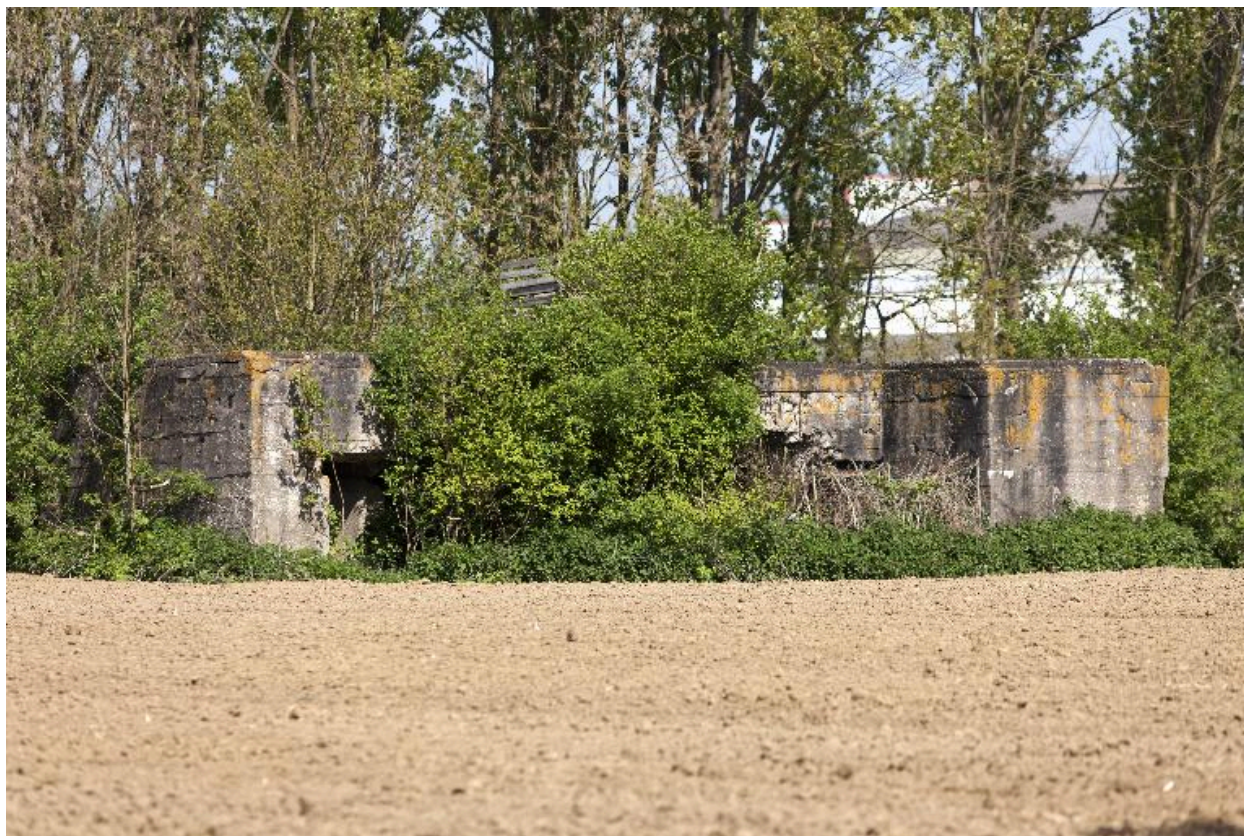
Vue rapprochée vers le nord
