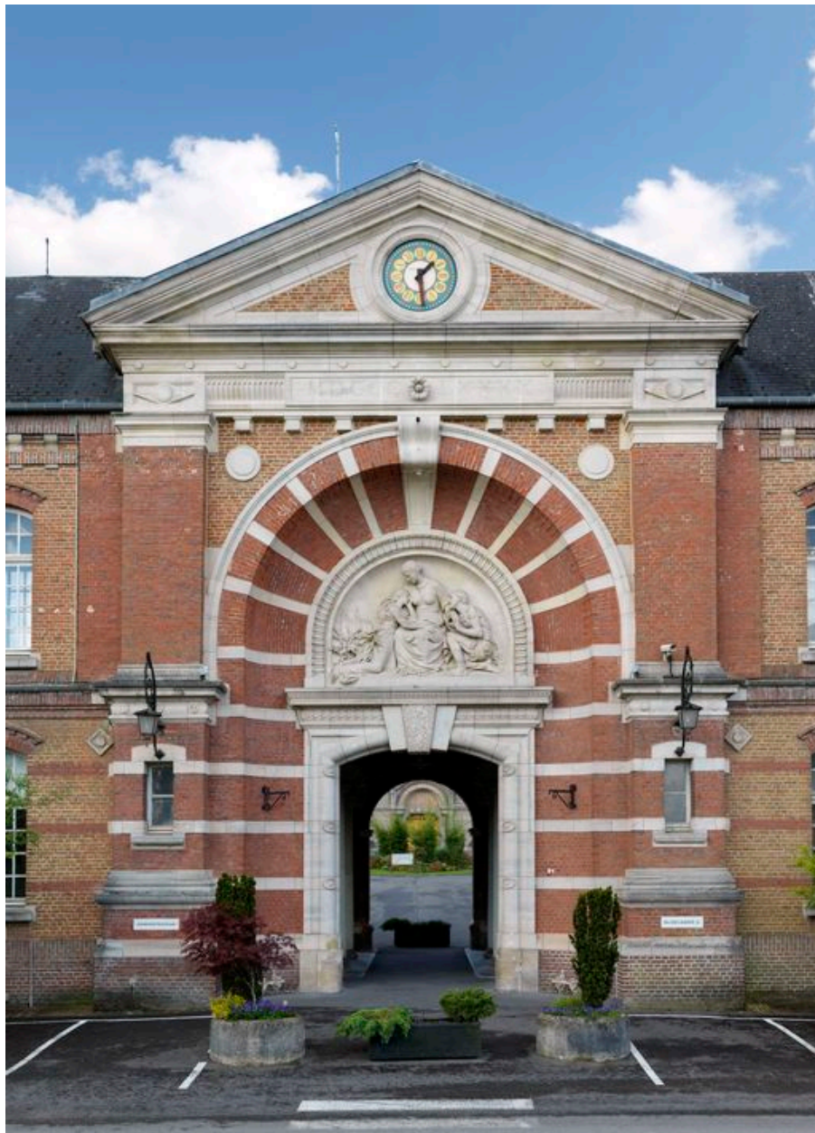
Travée centrale du bâtiment d'administration. Façade nord.
