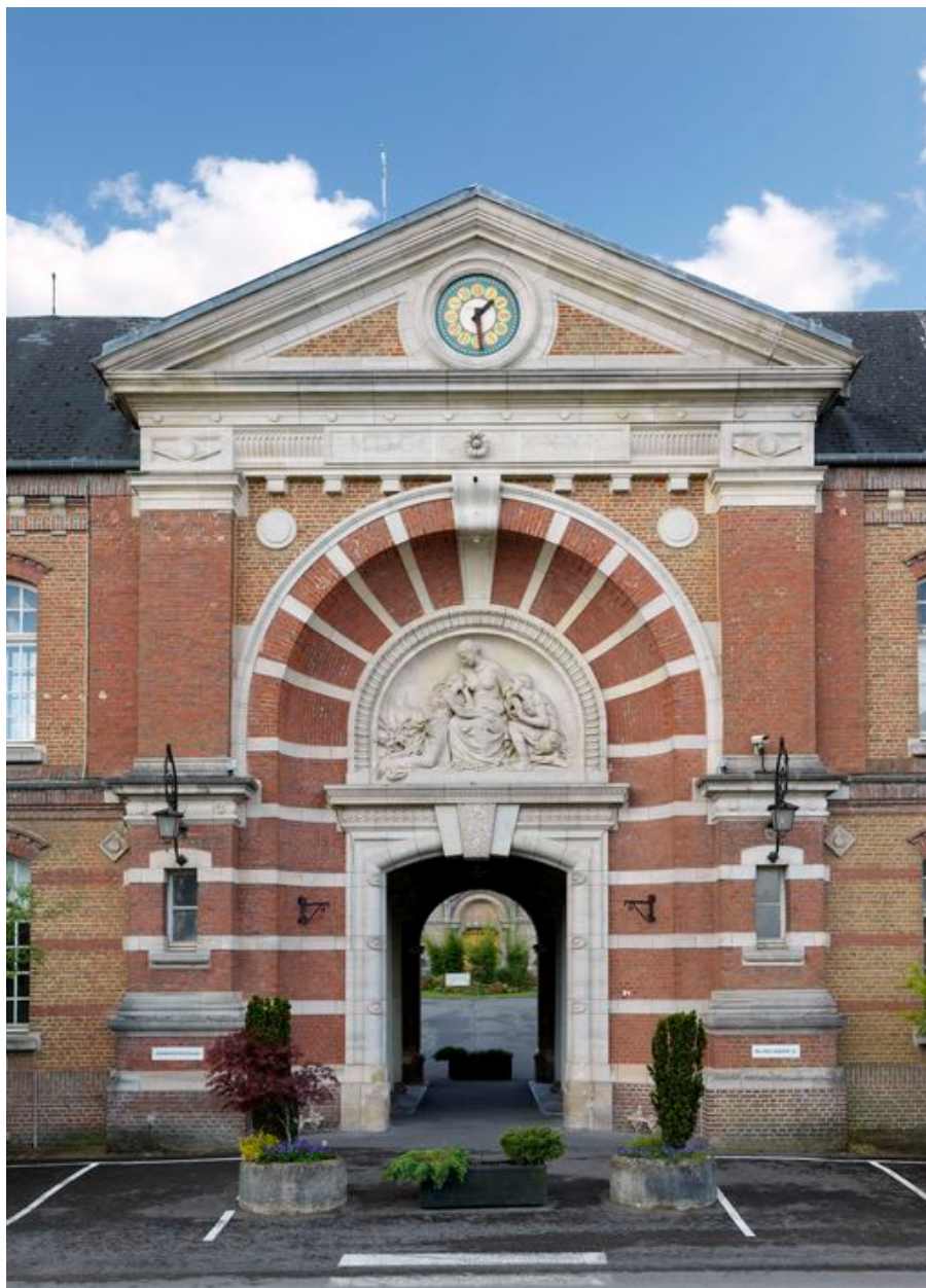
Travée centrale du bâtiment d'administration. Façade nord.
