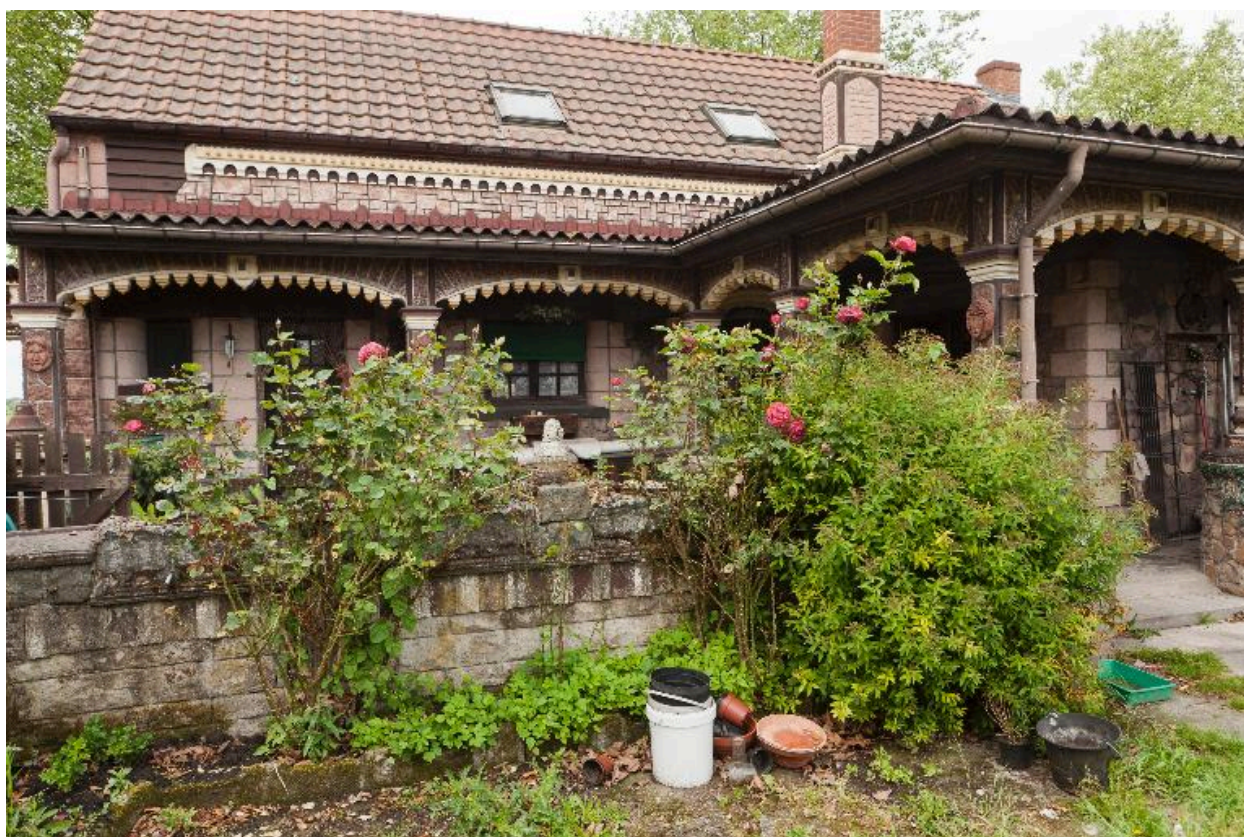
Vue partielle de la maison.
