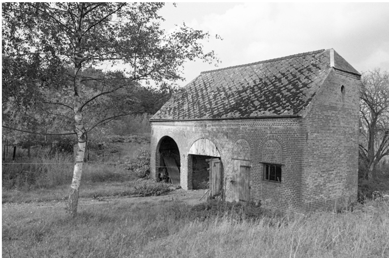
Vue d'ensemble de la remise, depuis le sud.
