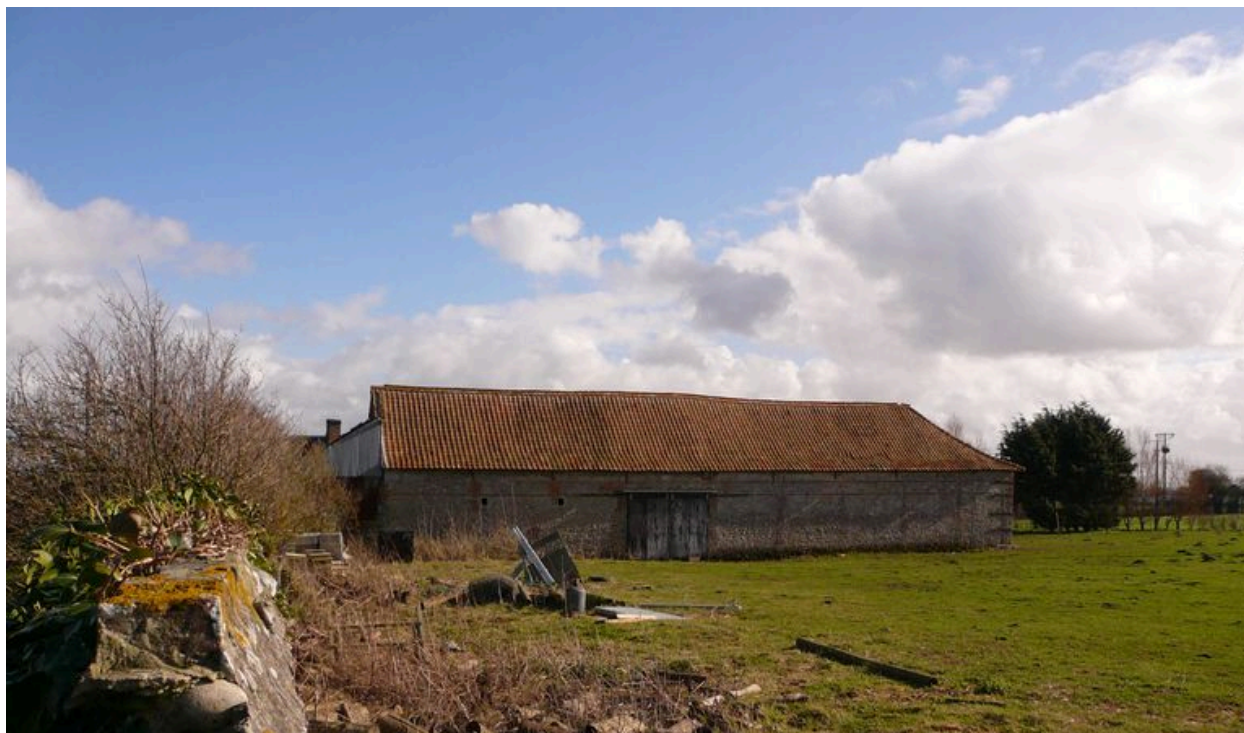
Vue postérieure de la grange depuis la pâture.
