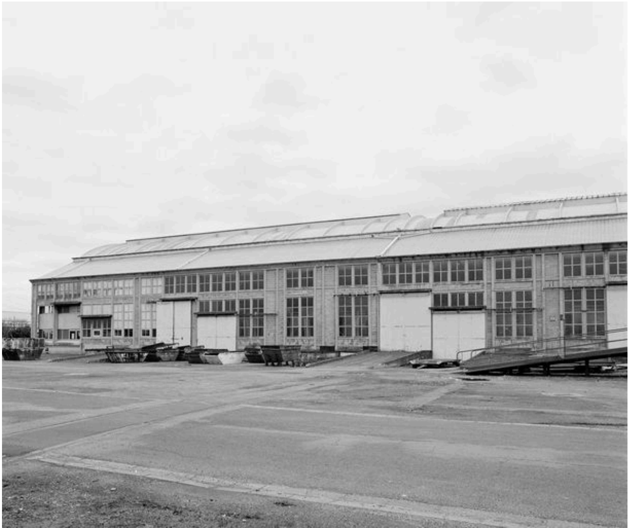
Façade longitudinale de l'ancienne ligne de fabrication, construite en 1922-1923.
