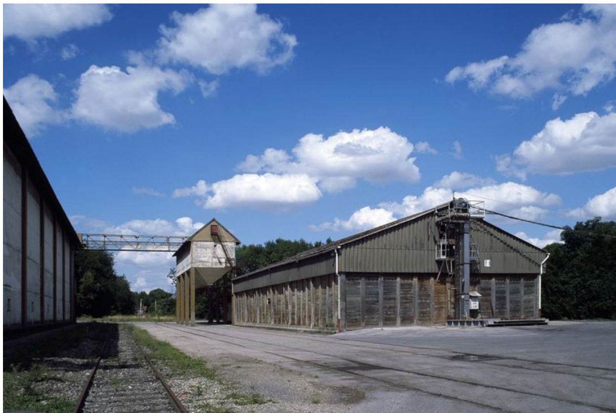
Vue du bâtiment de stockage et de la trémie établis à proximité de la voie ferrée.
