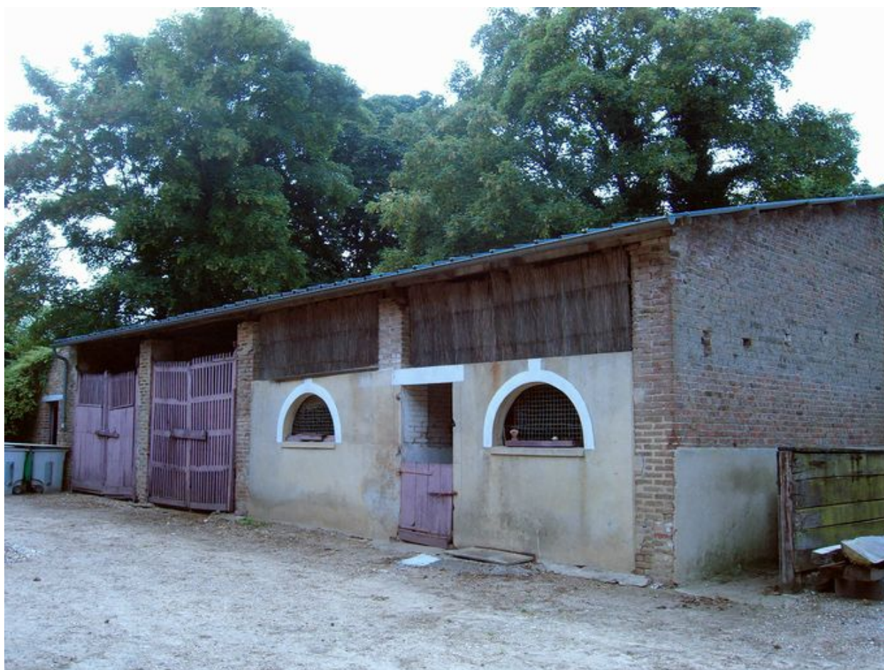
Vue de l'abri à voitures.
