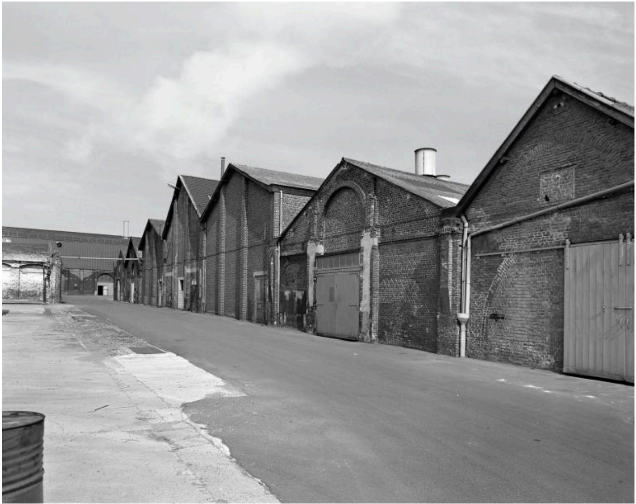
Vue extérieure des bâtiments industriels.
