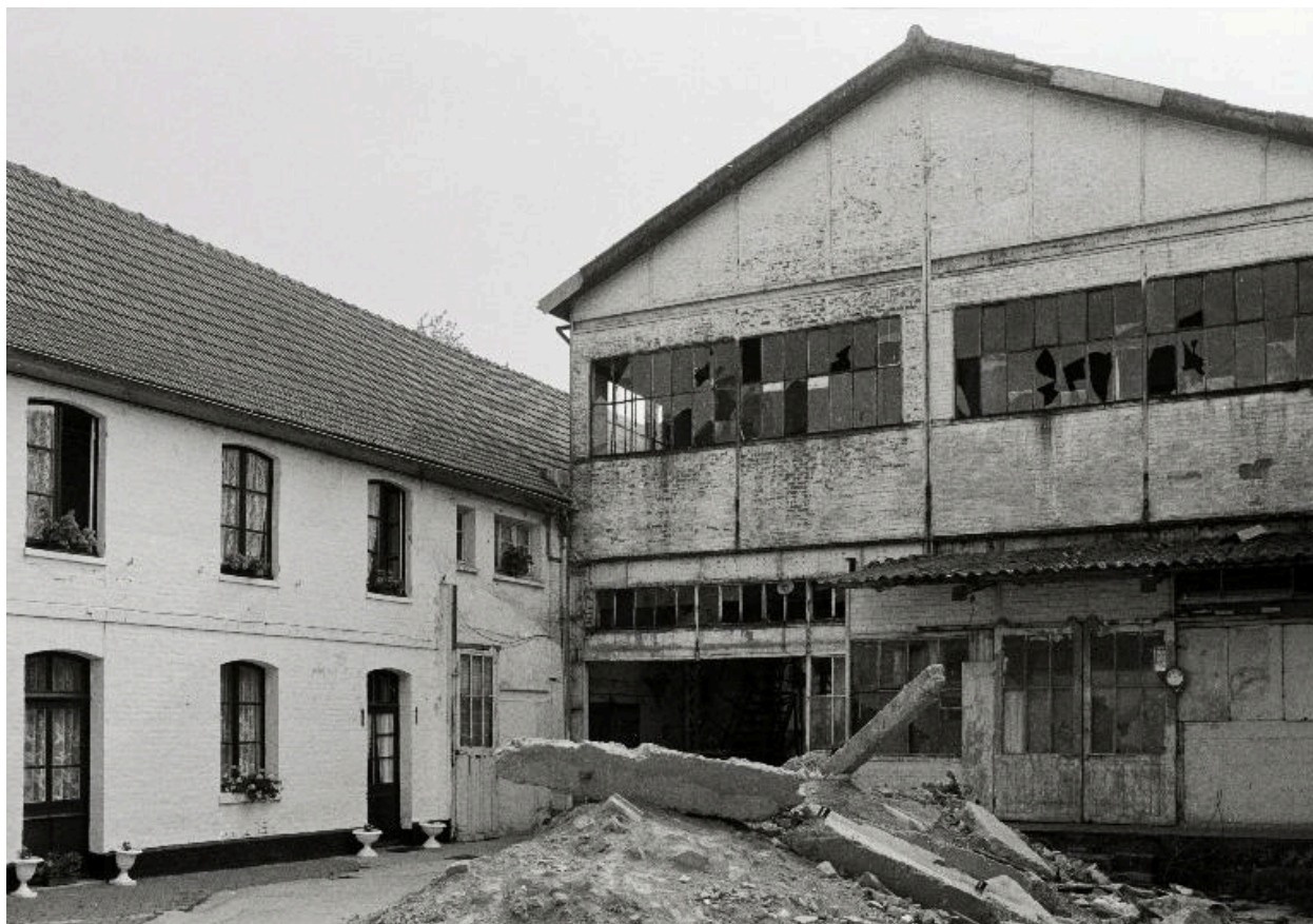
Atelier de fabrication, vue depuis la cour.
