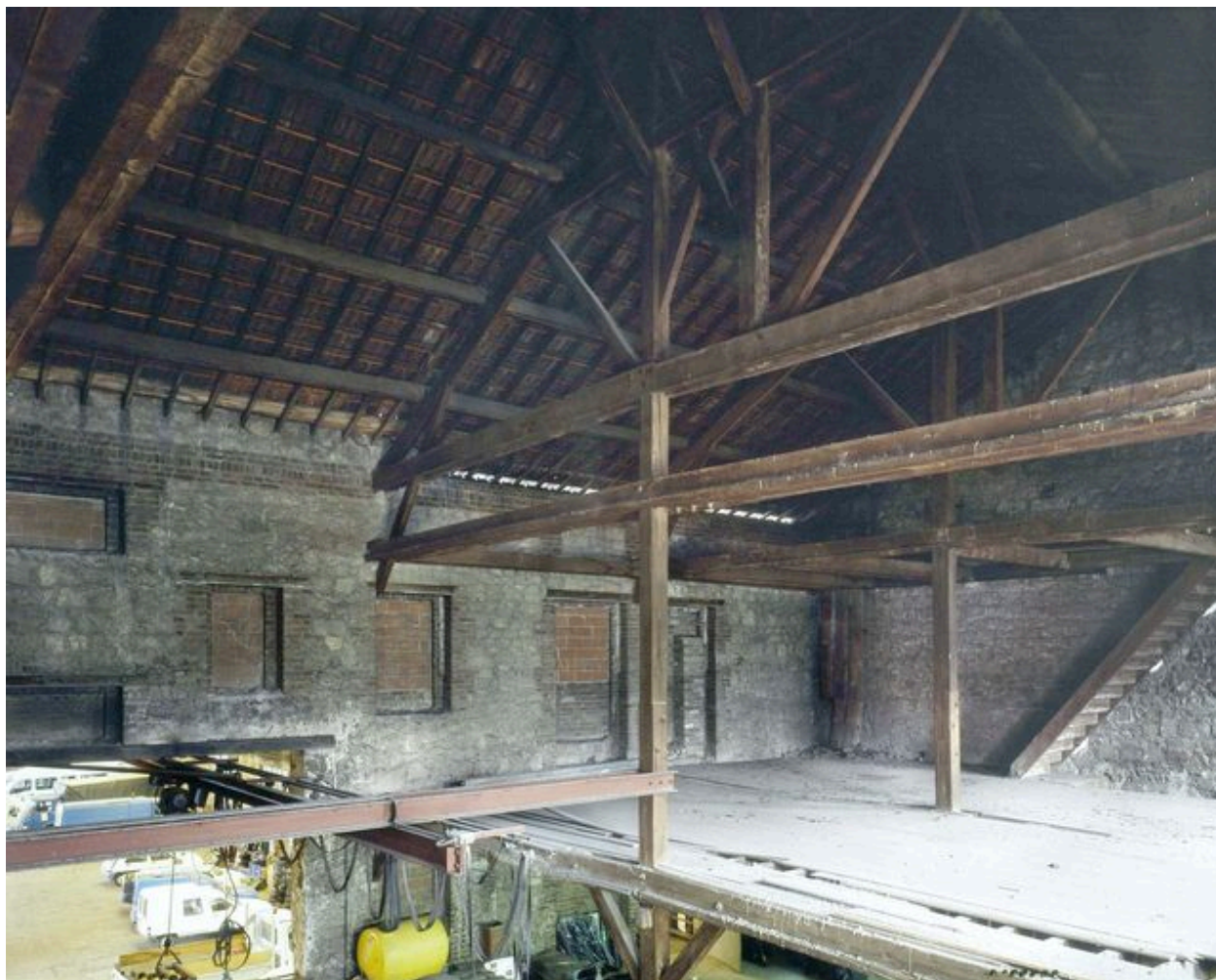
Plancher du premier étage de l'ancien relais de chevaux.
