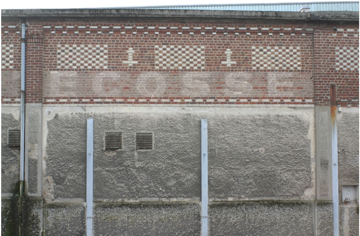
Détail du mur d'enceinte, rue de Guise.
