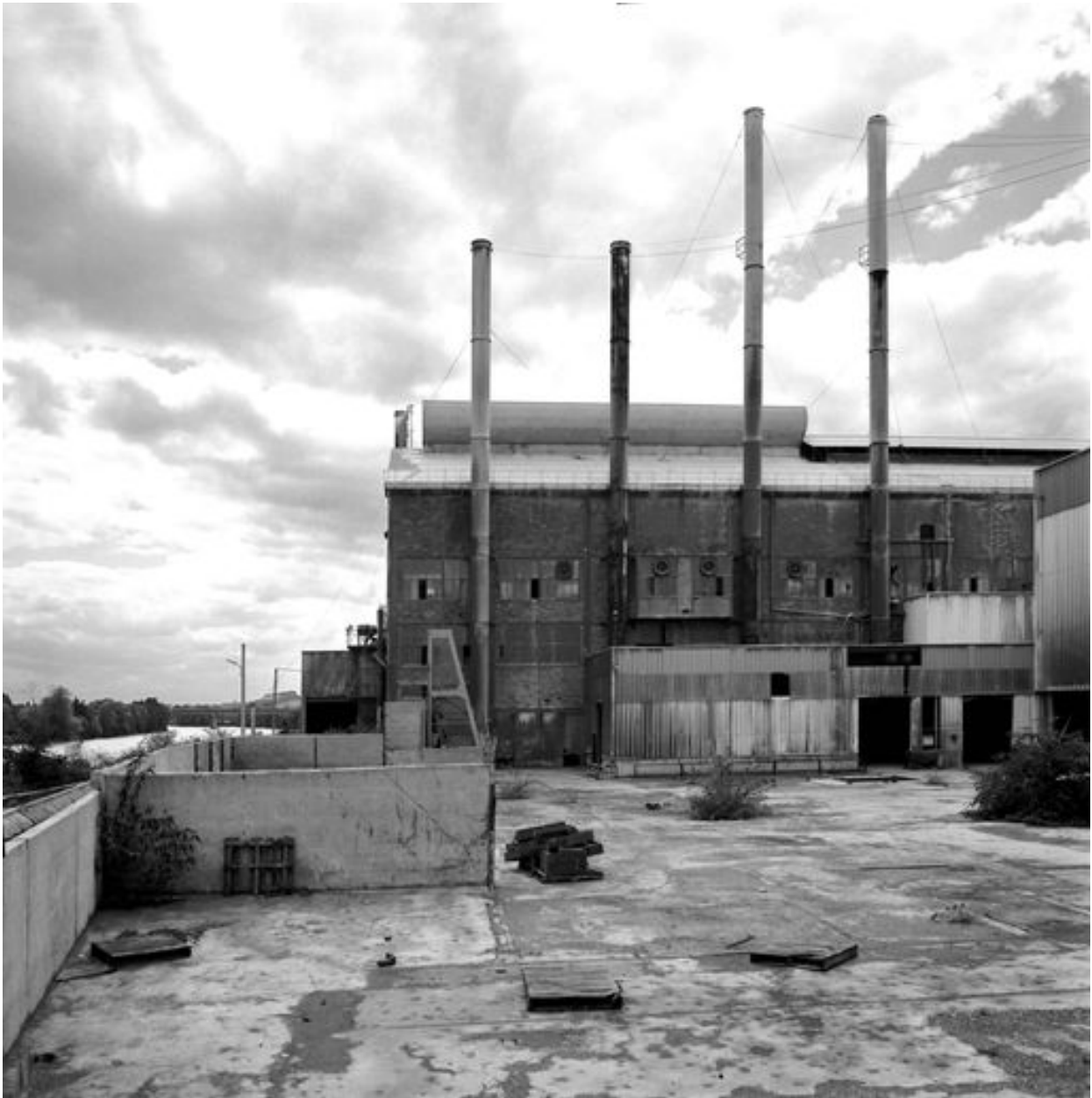
Façade nord-est du bâtiment abritant les fours, en cours de démolition, en 1999.
