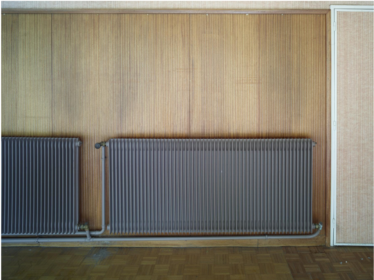
Détail du revêtement mural de la grande salle du deuxième étage.
