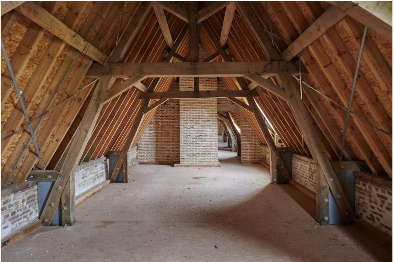
Combles. Logis du XVIIe siècle.
