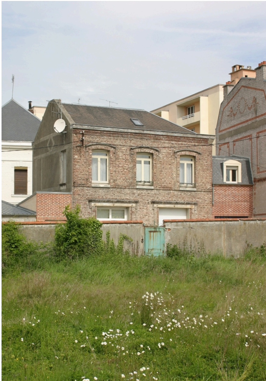
Ancien logement de contremaître : façade postérieure.
