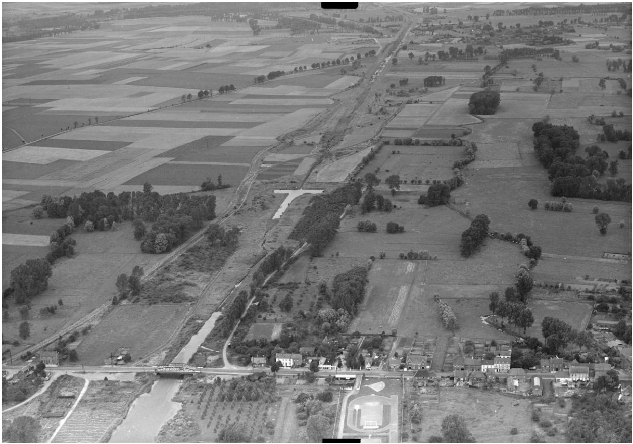
État du site écluse n°2 de Marquion (Pas-de-Calais) en 1958 avant la reprise des travaux en 1965 (IGN. Photothèque Nationale. 1958).
