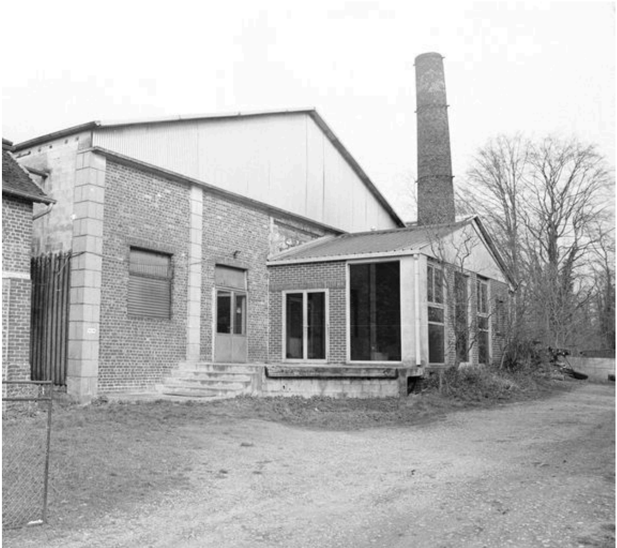
Vue générale extérieure du pignon ancien de l'atelier de fabrication depuis l'entrée de l'usine.
