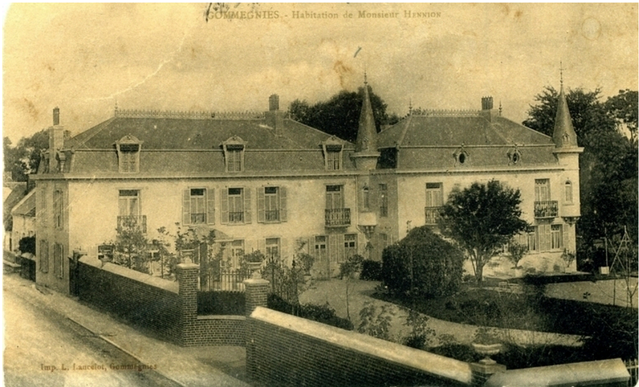
Vue générale, après les transformations des années 1890.
