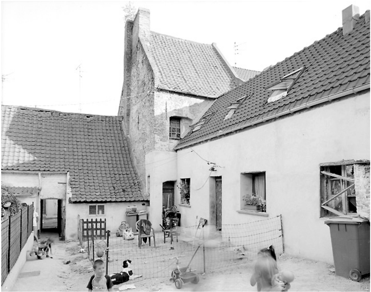
Courée, vue partielle : passage vers la rue Neuve et rang de maisons sud-ouest, dénaturé (état en 2002).
