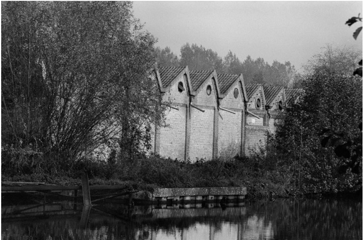
Les ateliers de fabrication, sur les bords du canal de la Somme.
