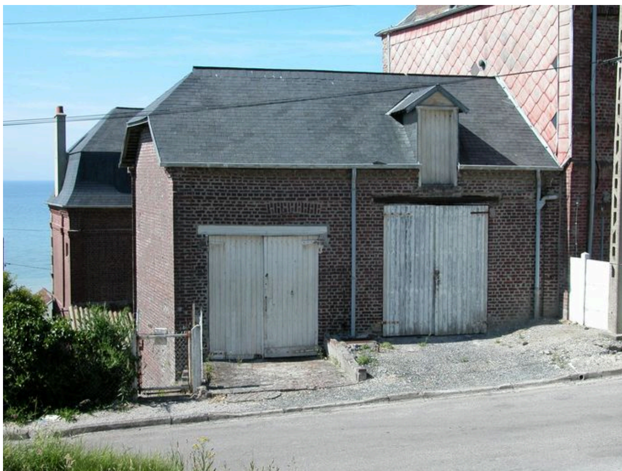
Les garages accessibles depuis la rue Léveillé.
