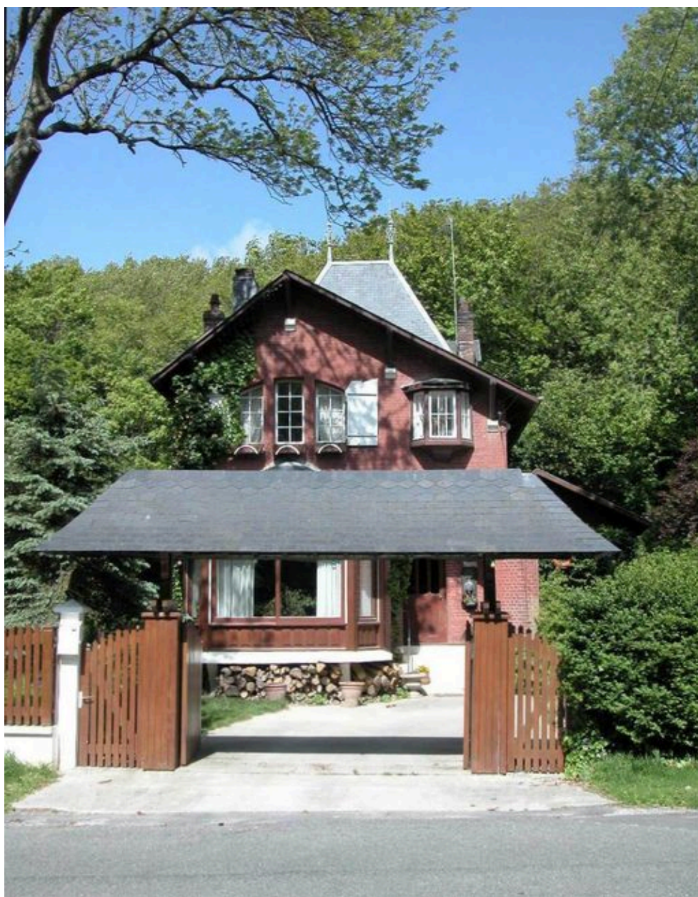
Elévation antérieure, vue depuis la rue.
