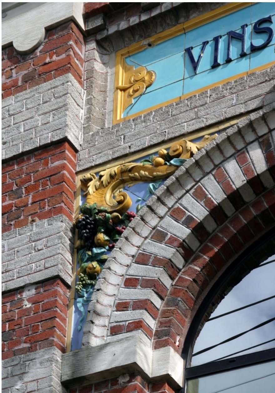
Façade antérieure, détail.
