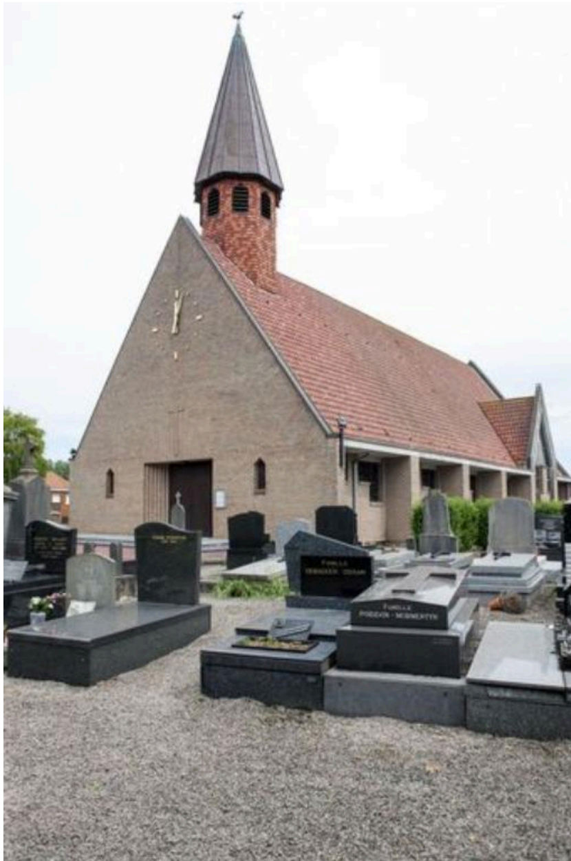
Élévation antérieure et flanc droit.
