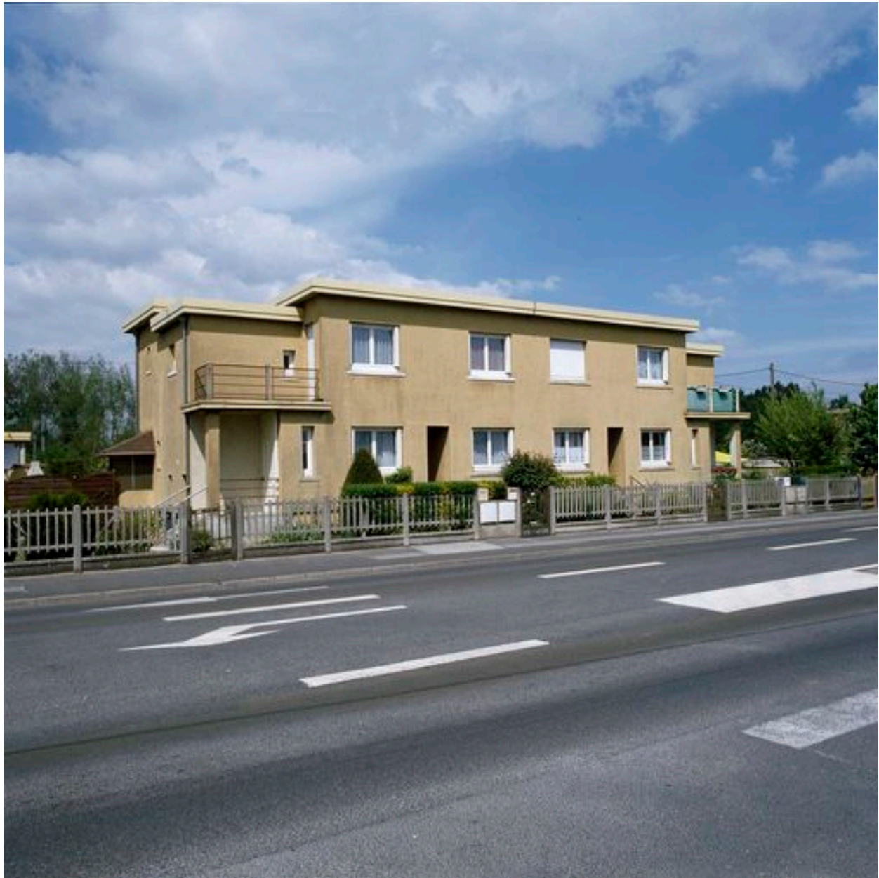
Maison à quatre unités d'habitation.
