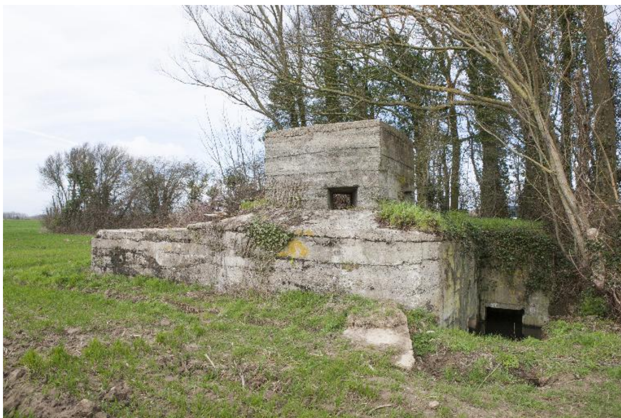
Vue générale, vers le nord-ouest
