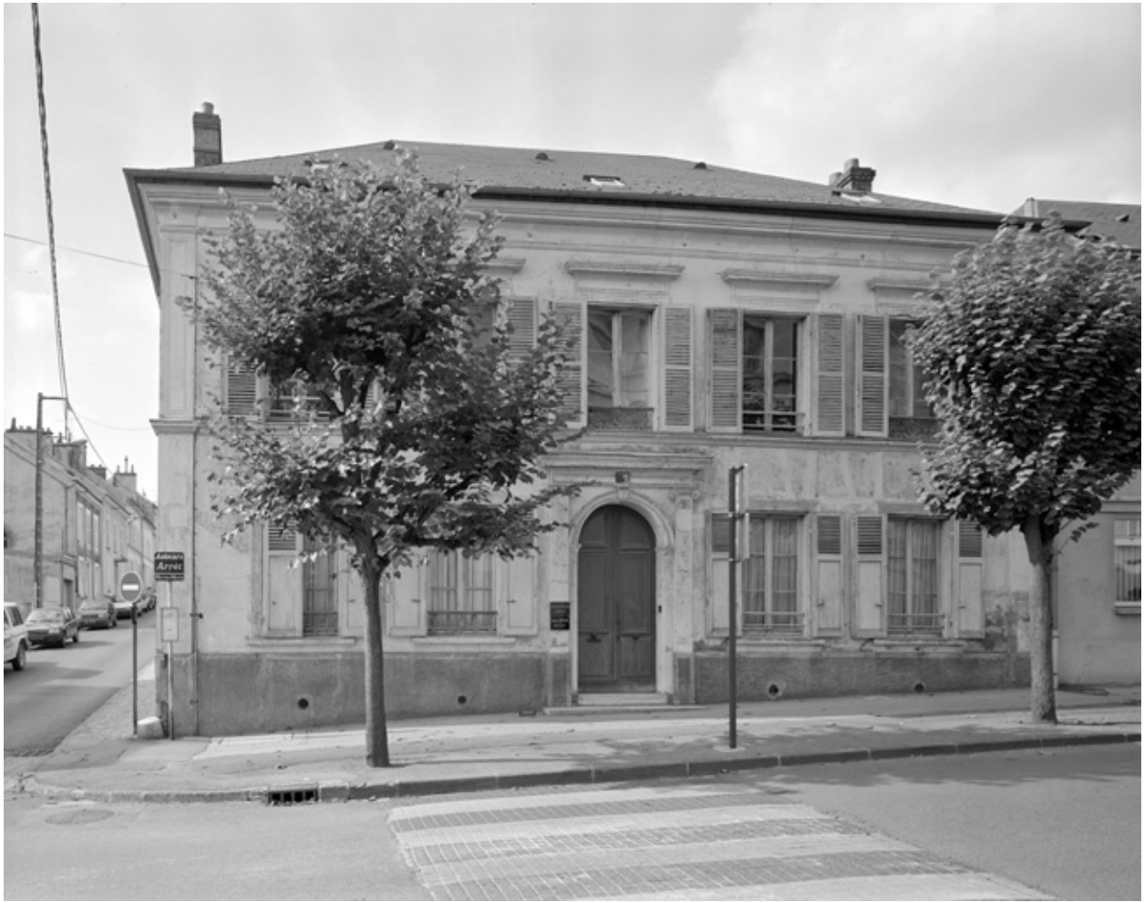
Maison, 32 avenue de Soissons.
