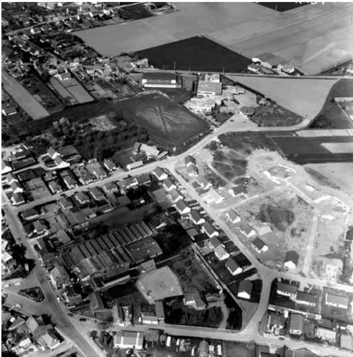
Vue aérienne, flanc sud-ouest.
