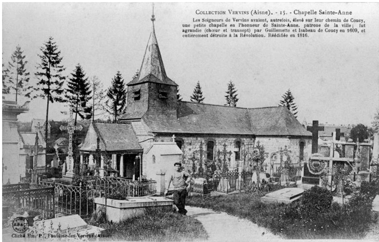
Vue générale de la chapelle, depuis l'ouest, avec le cimetière.
