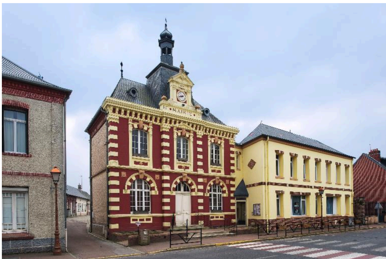
La mairie de Fressenneville.
