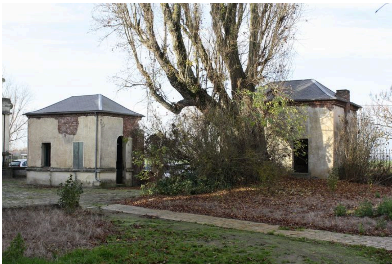
Vue d'ensemble des pavillons d'entrée de la sucrierie, depuis la cour.
