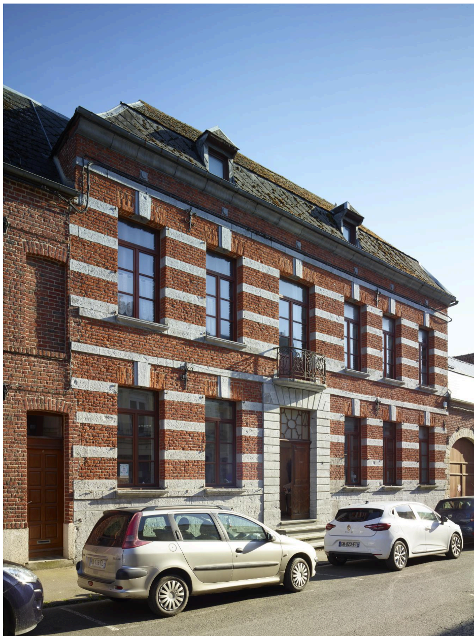
Maison de maître avec porte bâtarde, porte cochère et degré - 7-9, rue Georges V.
