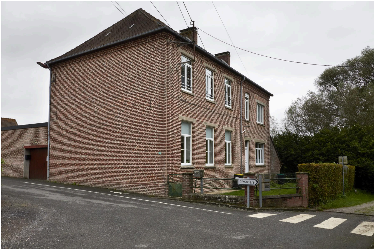
Façade sud et pignon ouest.
