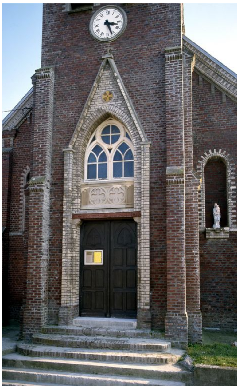
Détail de la façade occidentale.
