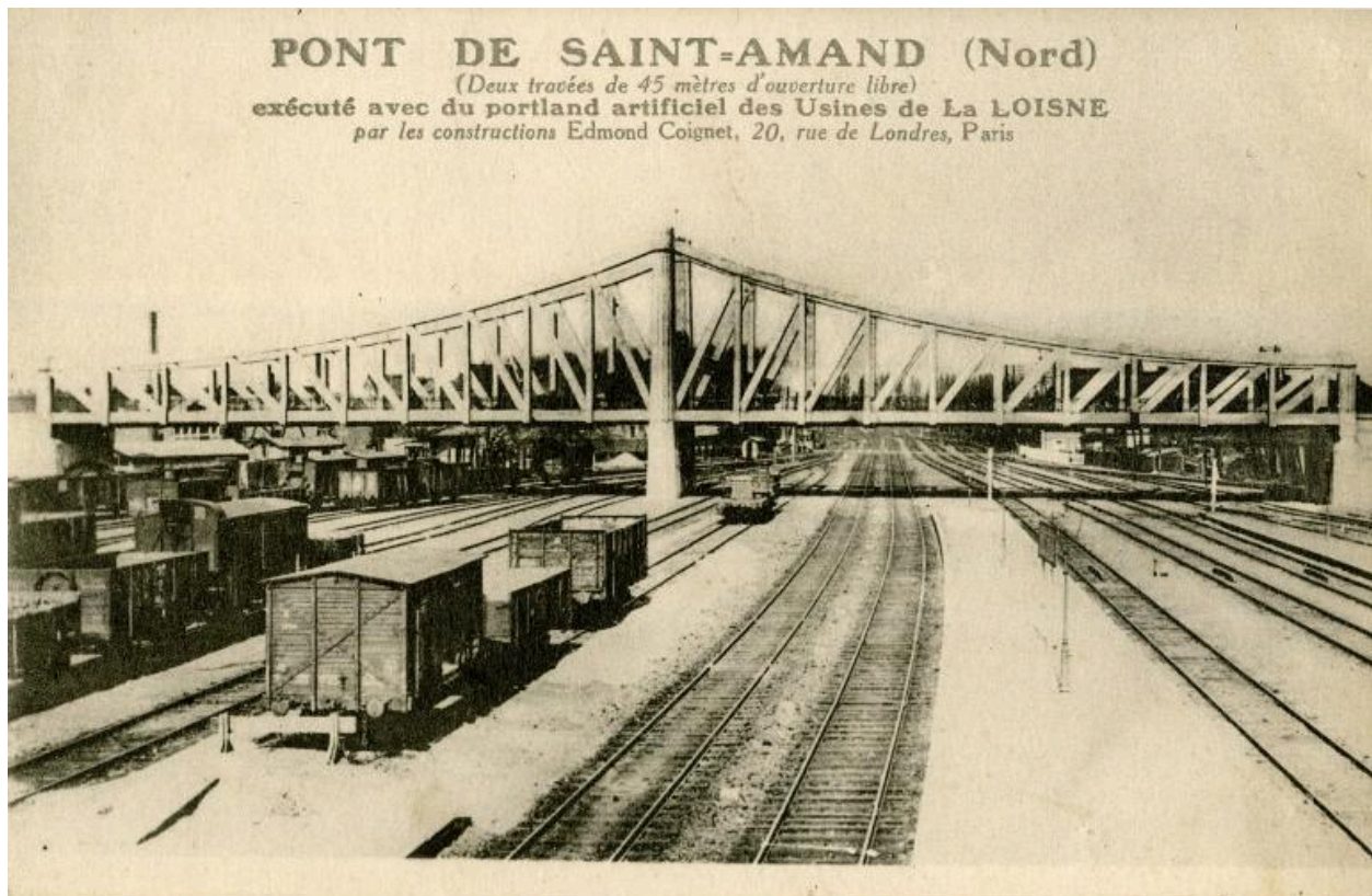
Pont de chemin de fer à deux travées de 45 m, réalisé par l'usine de construction Edmond Coignet, Paris, carte postale sans date (2e quart 20e siècle) (Médiathèque Saint-Amand-les-Eaux).
